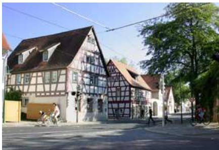
Fachwerkhäuser von Eberstadt
