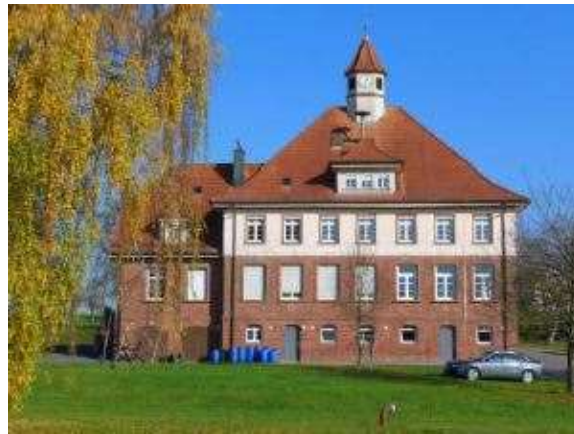
Alte Schule/Rathaus in Balsbach
