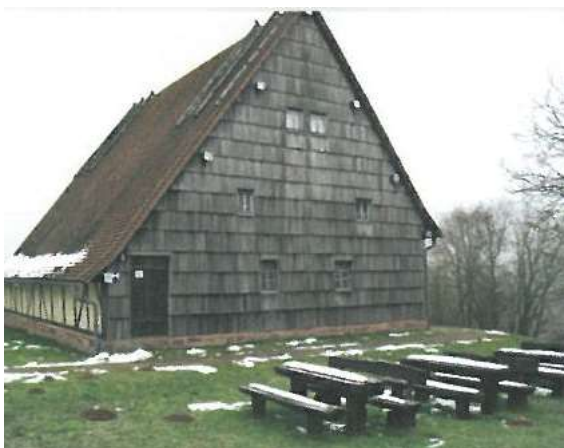
Das Watterbacher Haus
