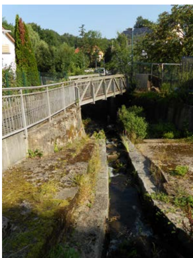
Brücke über den Lobbach, Waldwimmersbach
