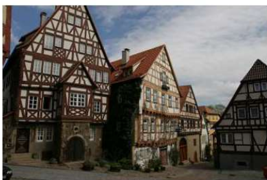
Fachwerk in der Altstadt
