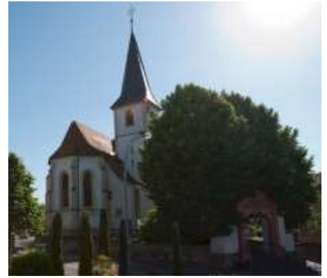
Katholische Kirche Bad Langenbrücken
