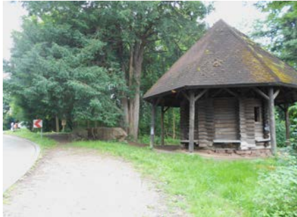
Blockhütte, Straße zwischen Heidelberg und Gaiberg
