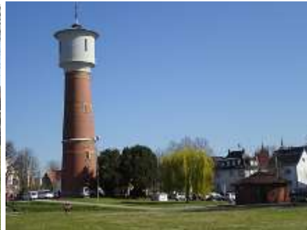
Der Wasserturm im Benzpark
