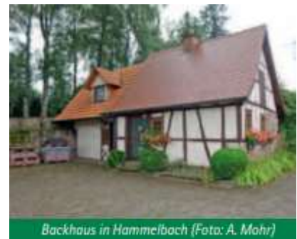
Backhaus in Hammelbach (Foto: A. Mahr)
