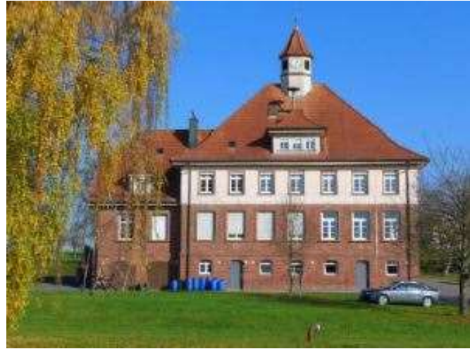
Alte Schule/Rathaus in Balsbach
