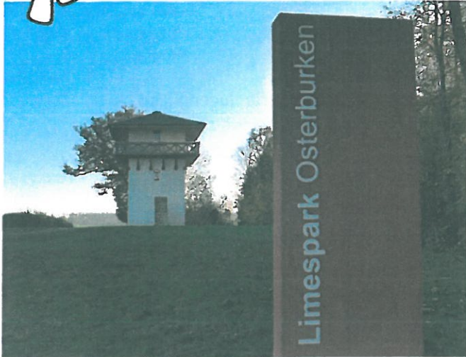
Ein Besuch des Limesparks lohnt sich nicht nur des Wachturms wegen.
