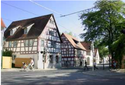
Fachwerkhäuser von Eberstadt
